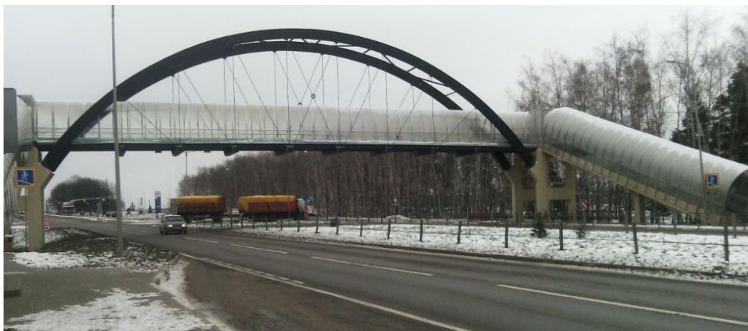
Рис. 17. Деревянный пешеходный мост в с. Ломово
